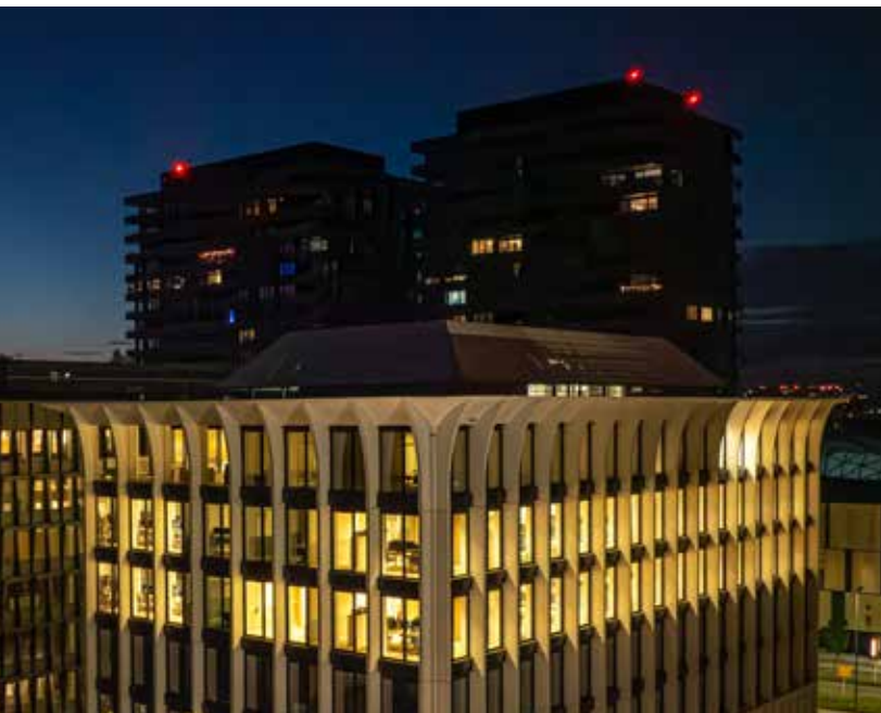
Nextensa • Kantoorgebouw White House op Cloche d'Or, Luxemburg
