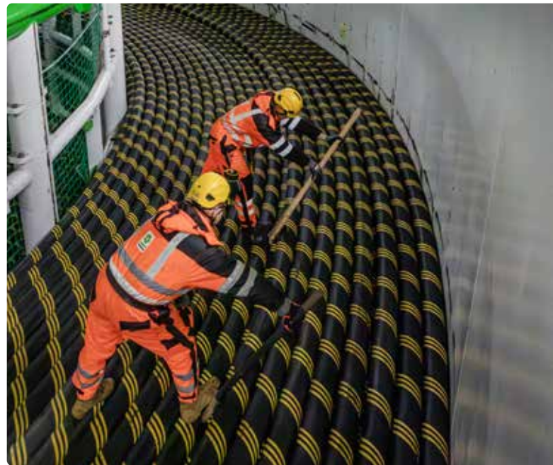
DEME • Kabelinstallatievaartuig 'Viking Neptun'
