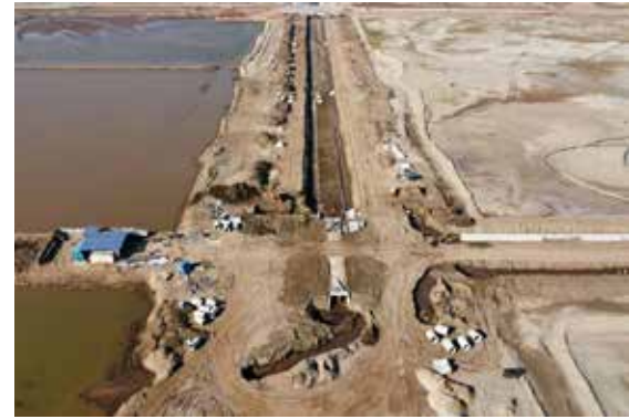
Deep C Holding • Landwinning en aanleg van een drainagekanaal op een industriële zone, Vietnam
