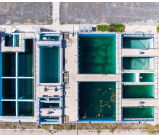
Deep C Holding • Installatie voor afvalwaterbehandeling op een industriële zone, Vietnam.
