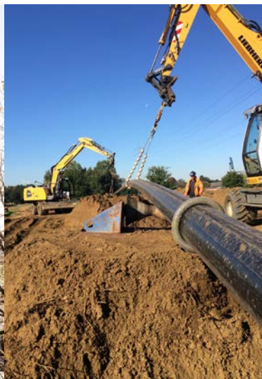
NMP - Pijpleiding Antwerpen-Kempen
