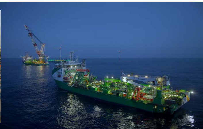
DEME &gt; Orion et Living Stone à l'œuvre dans le cadre du projet Coastal Virginia, États-Unis
